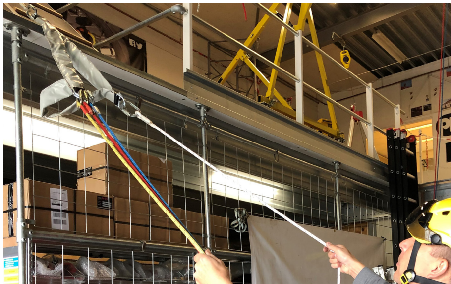
3. Lijnen begeleiden over het dak
