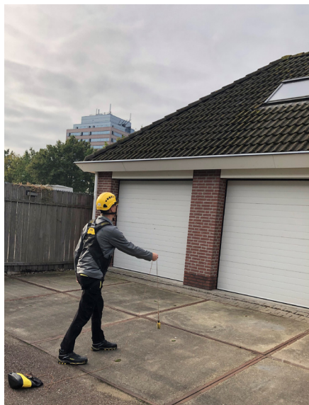
1. Werpgewicht over de nok van het dak werpen
