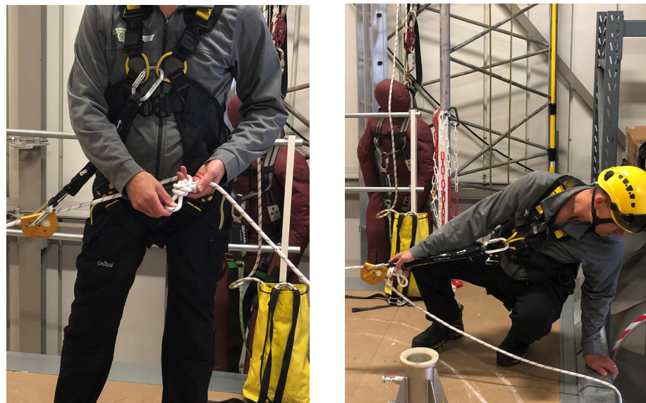
3. Trek eerst de schouderbanden aan, daarna de beenlussen en controleer of alle beenlussen goed zijn afgesteld
